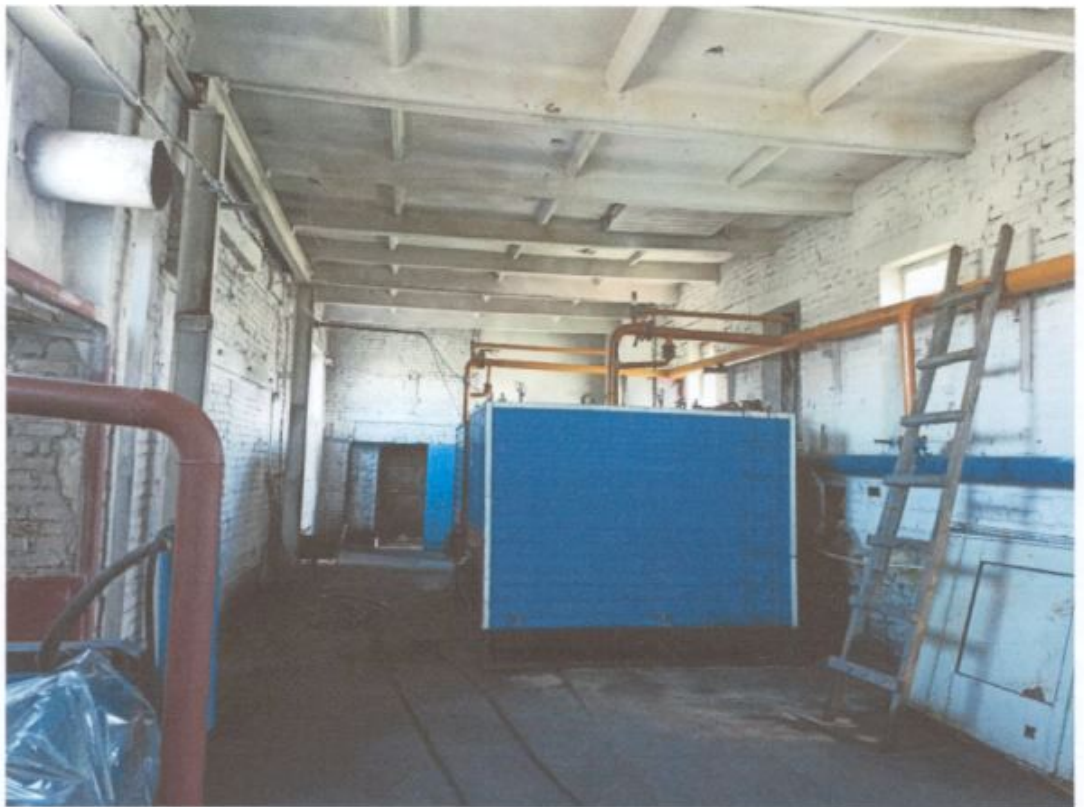
Общий вид помещений.
